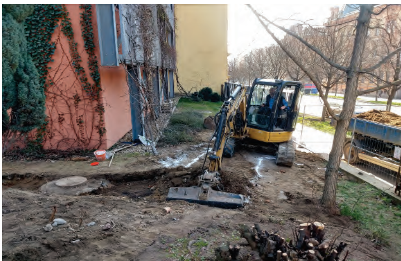
▲ Stavba schodiště a plotu
